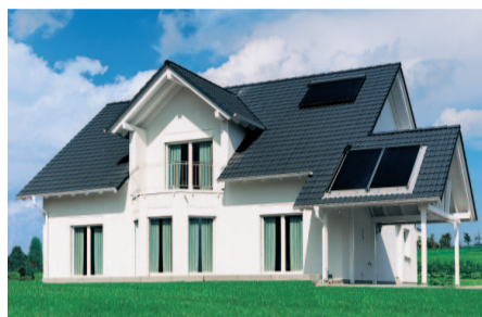
Kolektory słoneczne Vitosol 100 i 200 na dachu budynku jednorodzinnego.
