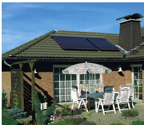
Próżniowe kolektory rurowe Vitosol 200 zamontowane na dachu budynku jednorodzinego.
