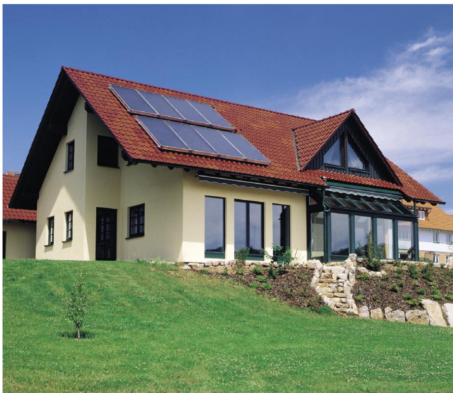
Fot. 2 Kolektory słoneczne Vitosol 100 na dachu domu jednorodzinnego.
