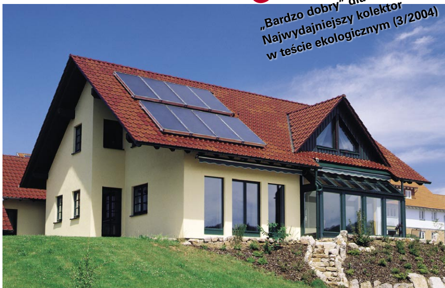
Kolektory słoneczne Vitosol 100 na dachu domu jednorodzinnego.
