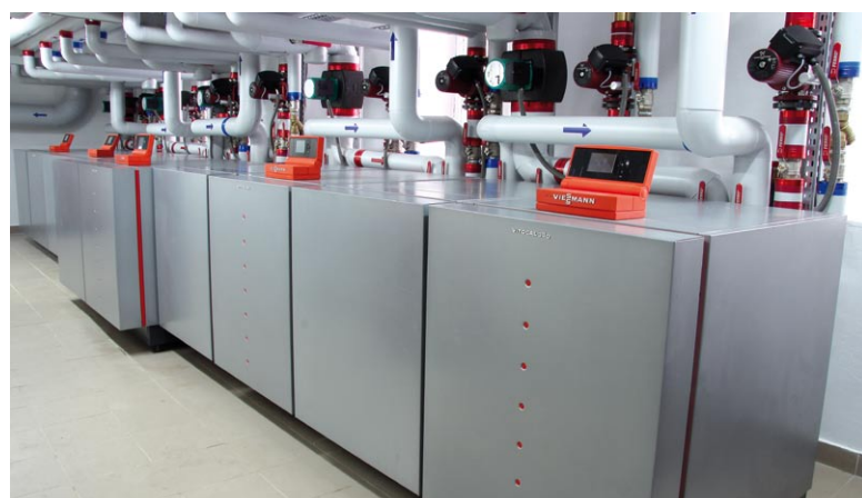
Pompy ciepła Vitocal wykorzystują ciepło natury zawarte w ziemi, wodzie lub powietrzu stanowi alternatywę dla paliw kopalnych.
