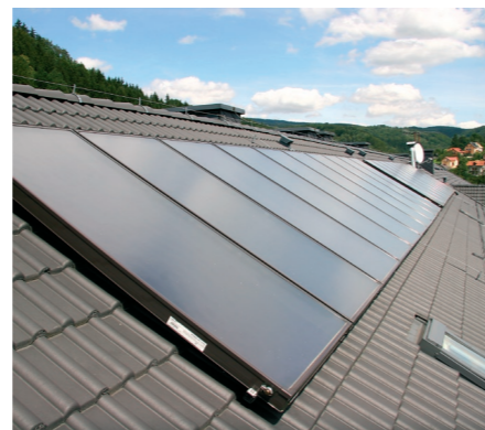
Bateria 20 kolektorów słonecznych Vitosol 200-F o łącznej powierzchni 46 m 2 – Hotel Verde Montana w Kudowie Zdroju
