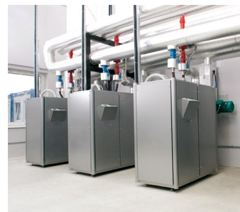
Pompy ciepła Vitocal pracujące jako układ kaskadowy w hali magazynowej w Rabowicach
