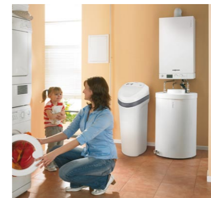
Jednym z najpopularniejszych rozwiązań jest połączenie kotła kondensacyjnego z pojemnościowym podgrzewaczem c.w.u.
