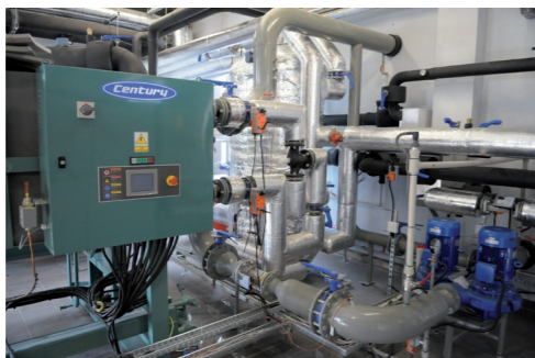
Energia, czyli prąd, ciepło i chłód, produkowana są z gazu ziemnego na miejscu w budynku, co pozwala ograniczyć straty przesyłu i zwiększa efektywność wykorzystania paliwa pierwotnego.
