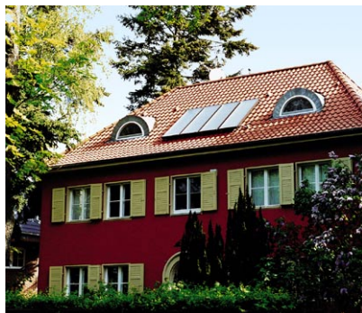
Kolektory słoneczne mogą być uzupełnieniem także już istniejących systemów grzewczych.
