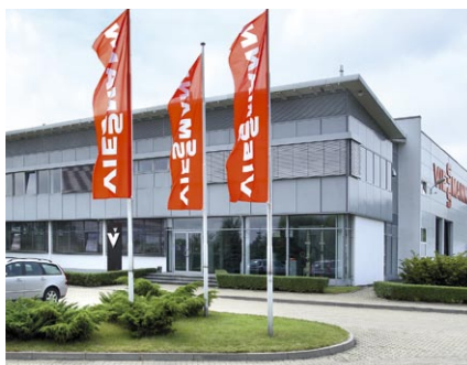
Centrum Nowoczesnej Techniki Grzewczej w Mysłowicach.
