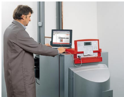
Pomoc techniczna w miejscu montażu urządzenia.
