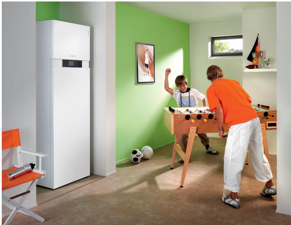
Powierzchnia zabudowy urządzenia wynosi zaledwie 600 x 670 mm, dzięki czemu technika pomp ciepła może być już stosowana w budynkach, gdzie nie przewidziano tradycyjnego pomieszczenia kotłowni.
